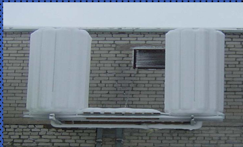
Iztvaicētāju intensīva apsarmošana vēsa un mitra laika apstākļos
