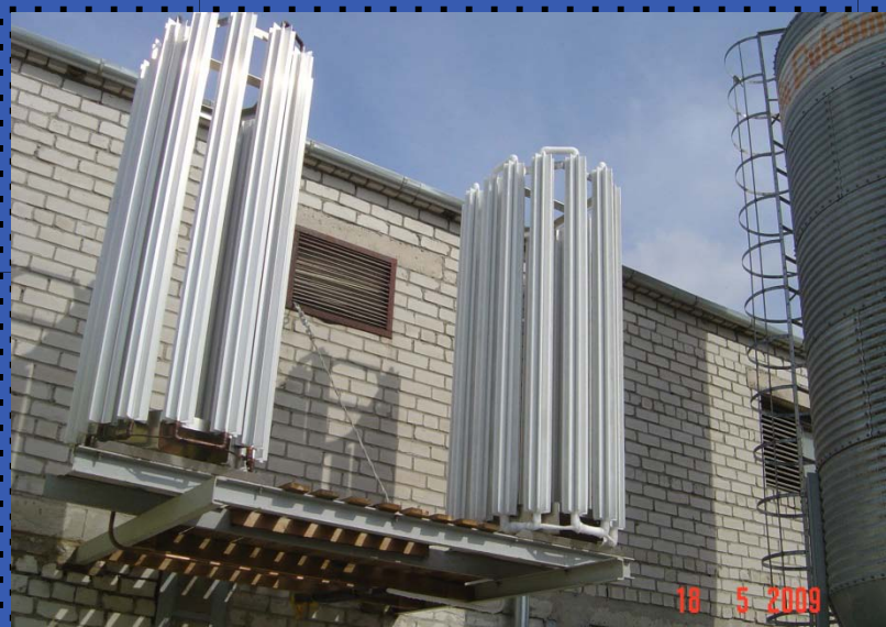
Siltuma sūkņa OCTOPUS IS 81 iztvaicētāji
